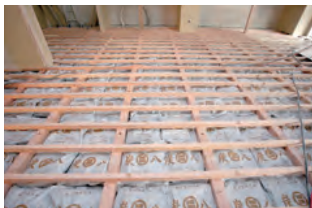
床下に敷き詰められた炭八
